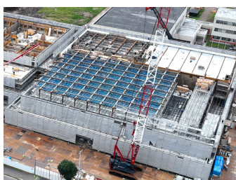
▲アリーナ棟の天井梁
