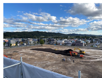
▲グラウンド工事の様子
