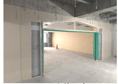
▲1F内装工事
