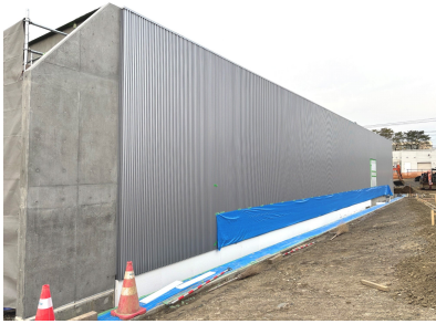
▲外壁ガルバリウム鋼板
