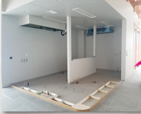
カフェキッチン工事
