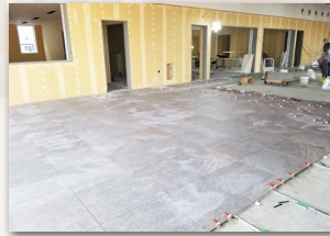
床タイル張り
