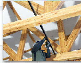
照明器具取付
