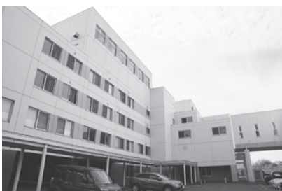
市立病院・南館
