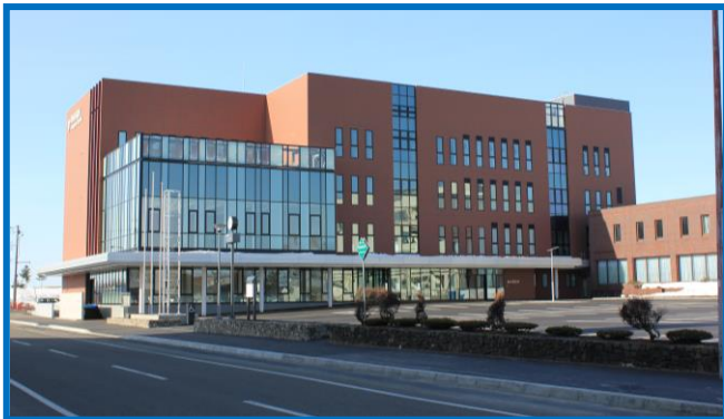
↑新庁舎の外観はこちらです。 教育委員会事務局は、新庁舎2階にあります。
