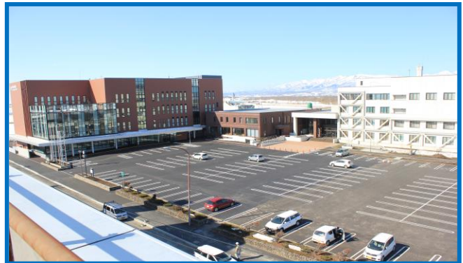
↑新庁舎移転のため昨年8月から行われた 駐車場工事も完了し134台が駐車可能です。
