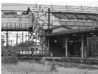
JR砂川駅東口整備
